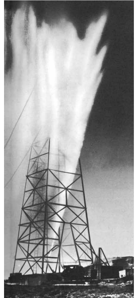
Artesisk brønn. Vannet strømmer ut med stor kraft og viser at trykket i brønnen er høyt
